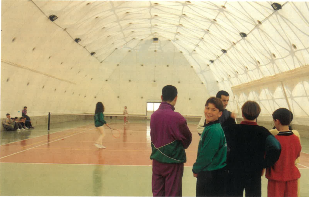
Monreale: struttura geodetica 1.000 mq Geodetic structure 1.000 square metres
